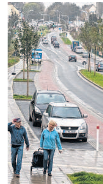
Die Durchstreckung der Fulerumer Straße ist fast abgeschlossen.
